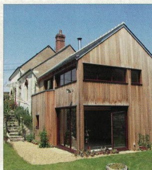
Maison à Bléré, F. GAETÉ architecte.
